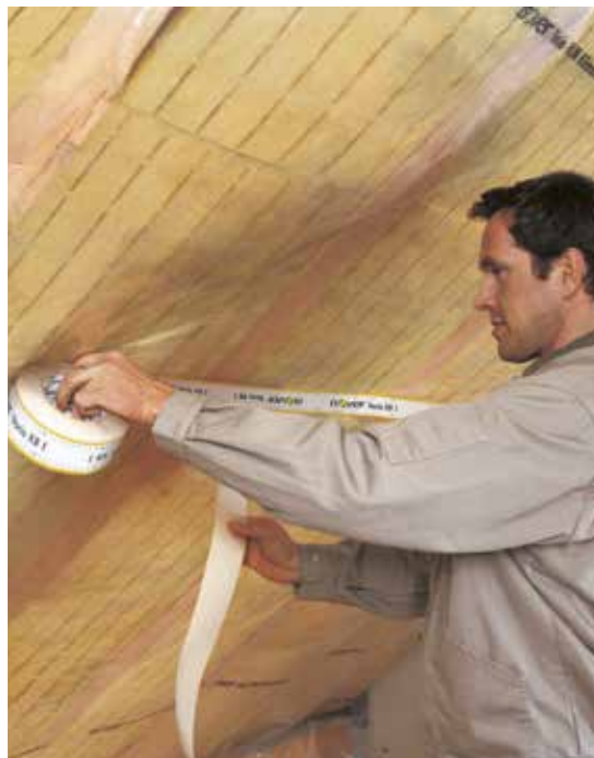
Ugradnja Vario® KM u kosinu krova
